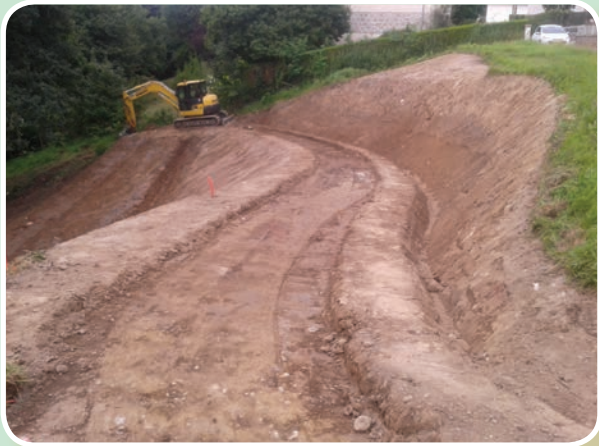
Travaux en cours
