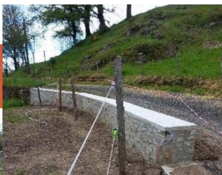
Réfection d'un mur de soutènement à Ydes-Bourg
