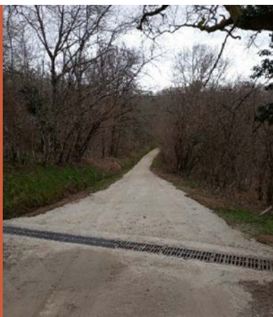
Pose d'un caniveau accodrain et reprofilage du chemin des côtes de Fanostre
