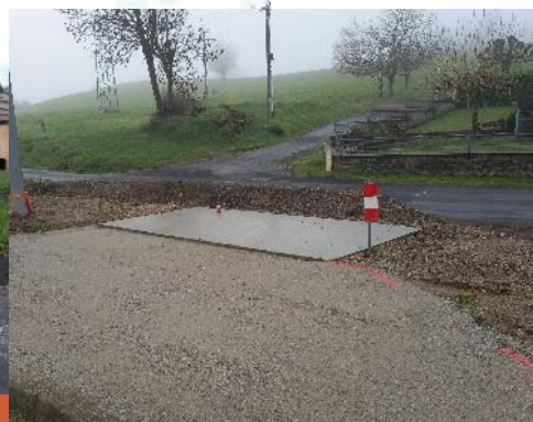
Réalisation des dalles pour les abribus
