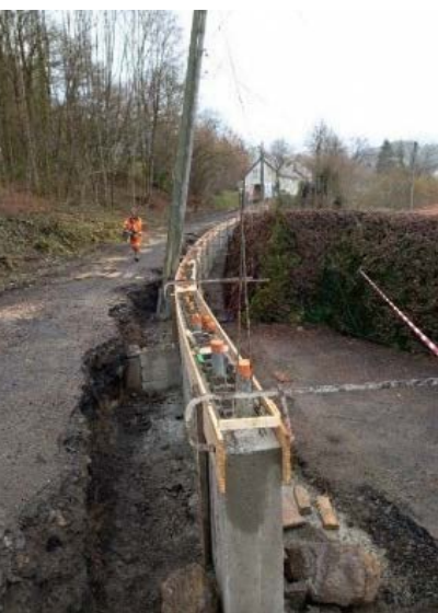
Construction d'un mur de soutènement Rue Jean Racine
