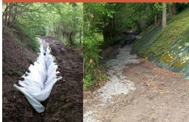
Drainage et empierrement d'un chemin rural à Lagnac
