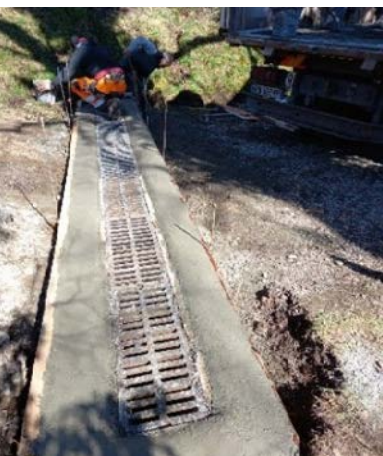
Pose d'un caniveau accodrain et reprofilage du chemin des côtes de Fanostre
