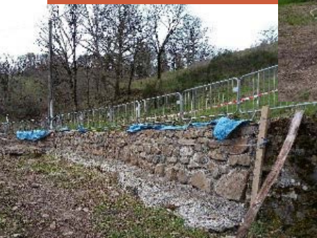
Réfection d'un mur de soutènement à Ydes-Bourg
