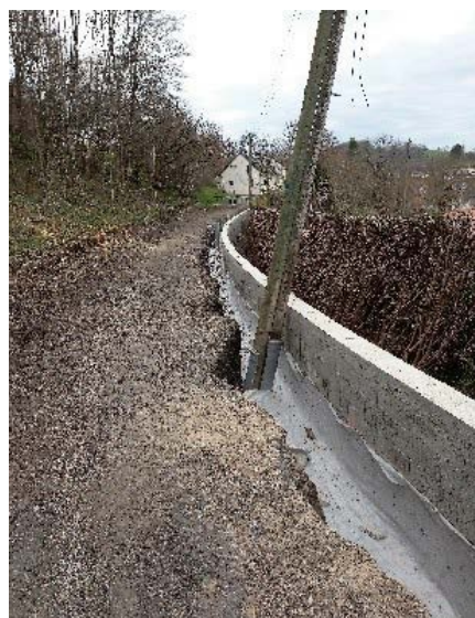
Construction d'un mur de soutènement Rue Jean Racine
